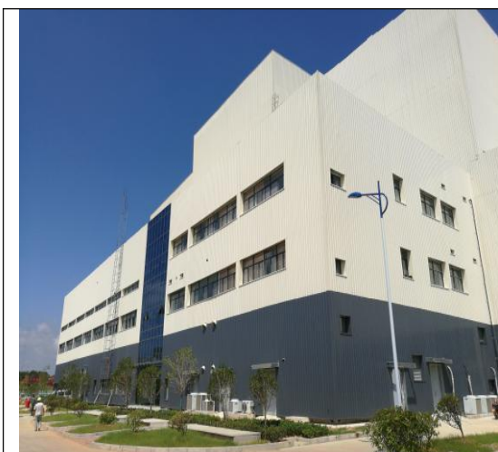
密封处理的垃圾锅炉房
