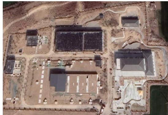
东城河调蓄站
