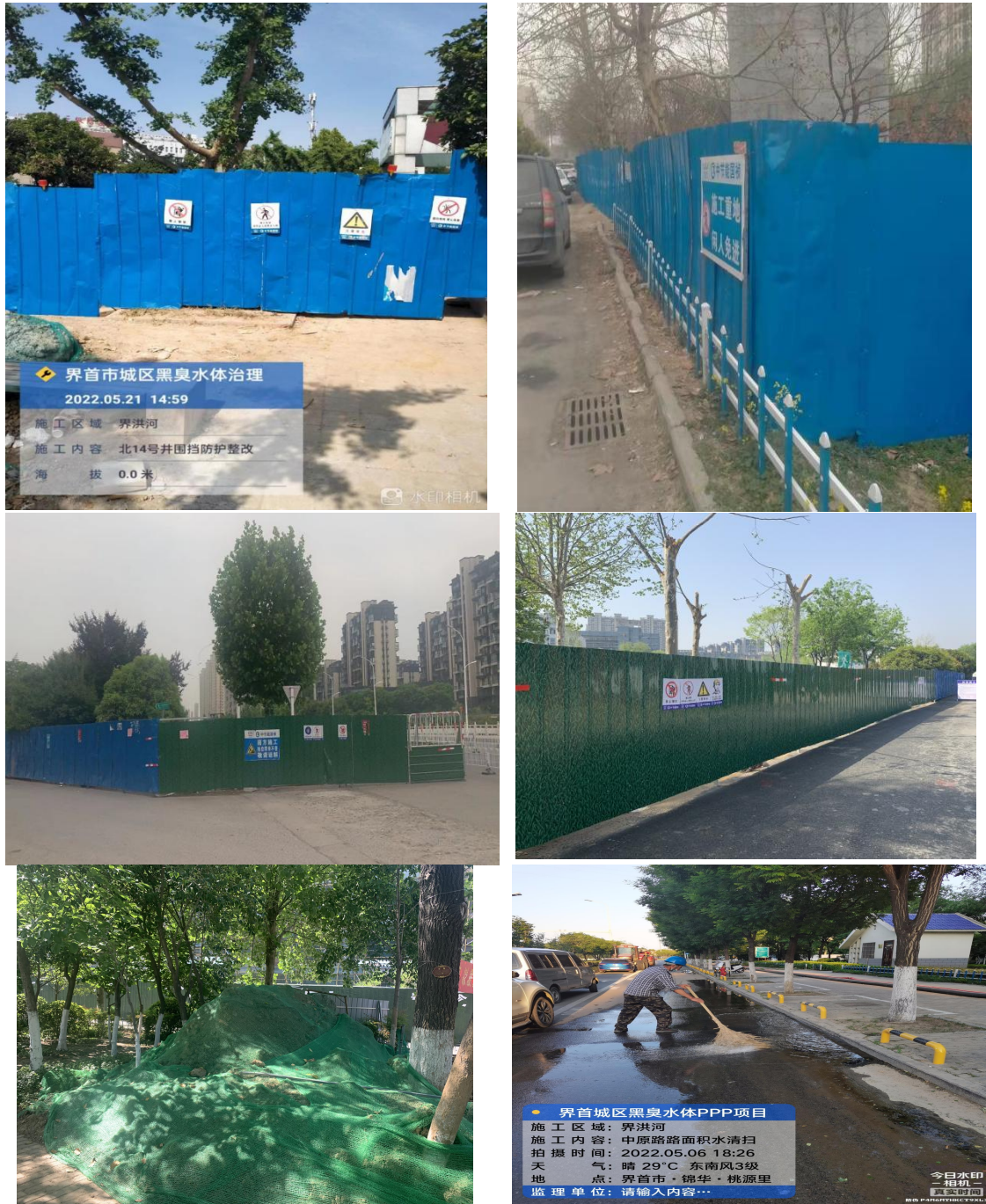
设置围挡降低噪声对周边的影响
