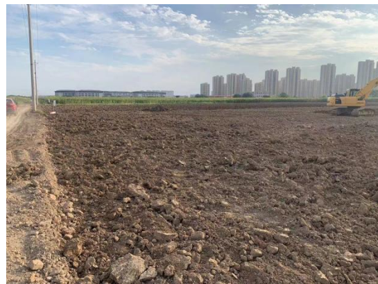
临时抛泥区占地恢复
