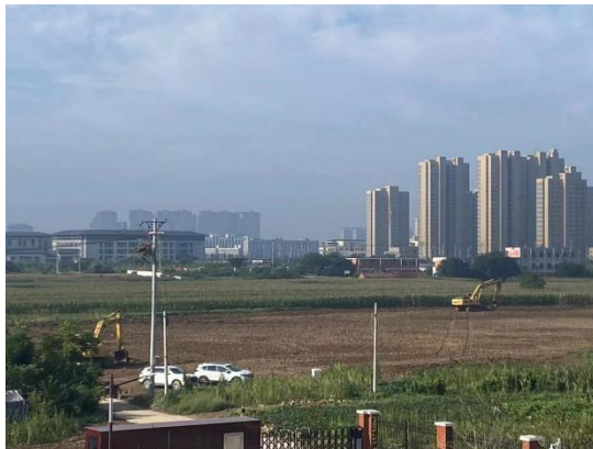
临时抛泥区占地恢复
